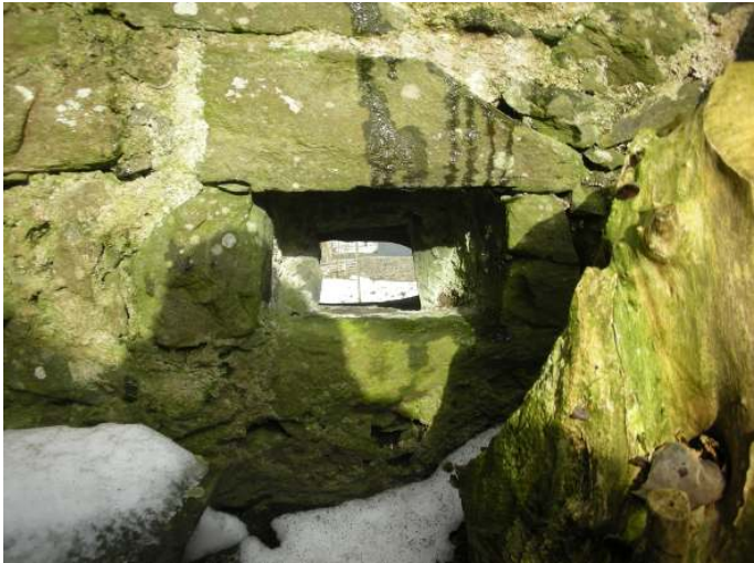
Outwork gun-loop (D) internal
